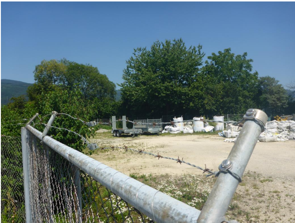
Objekt 2.01: Trafostation / Brunnmatt
